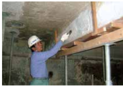
STEP2 躯体補修 (樹脂モルタル)
