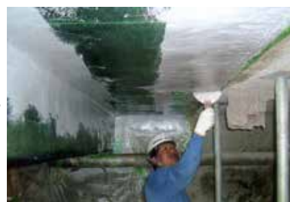
STEP6 エポキシ樹脂ライニング
