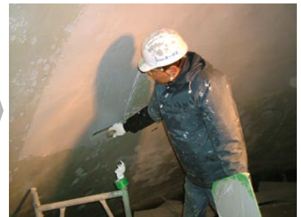
STEP3 素地調整 (エポキシ樹脂)
