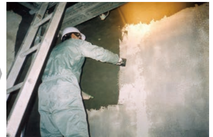
STEP3 素地調整 (水性エポキシモルタル)
