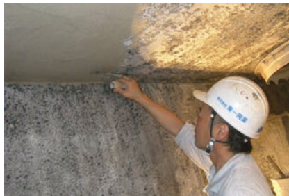
STEP2 躯体補修 (耐硫酸性モルタル)
