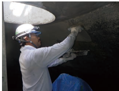
STEP2 躯体補修 (耐硫酸性モルタル)
